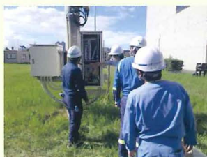
発電機接続訓練
