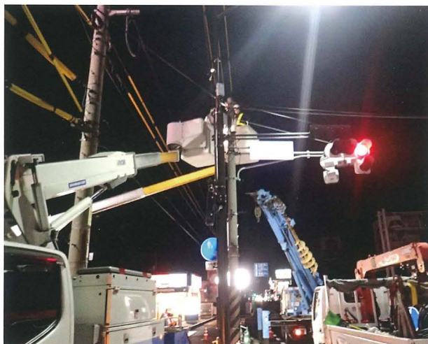
(夜間復旧作業中)
