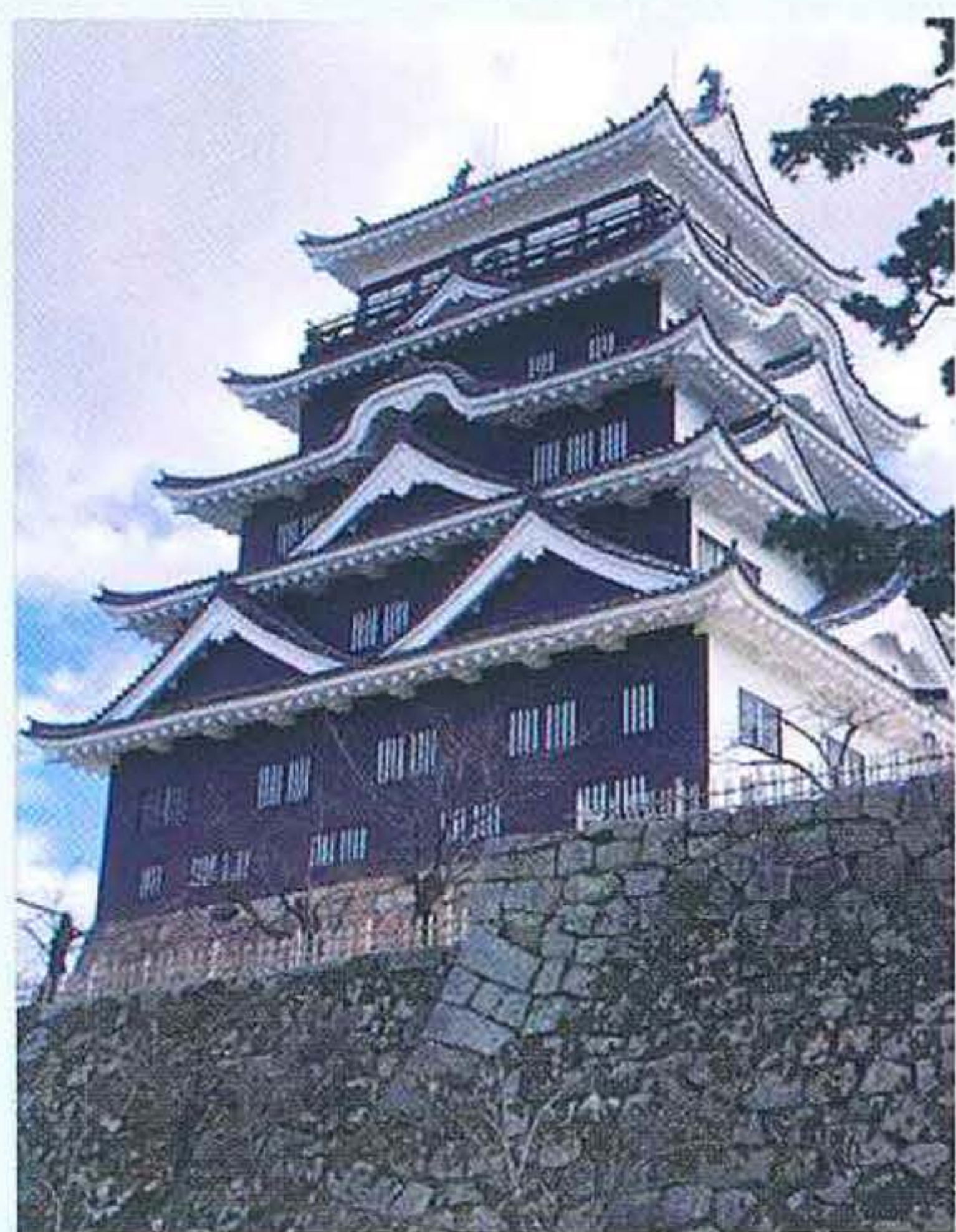
天守北側の鉄板張り
