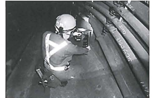
新幹線トンネル内への金物取付
