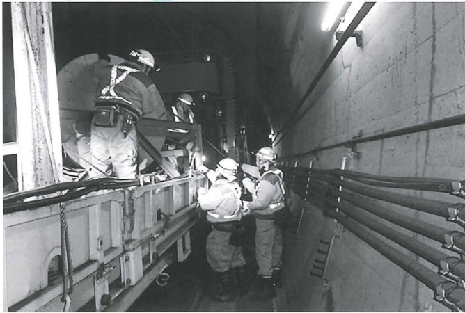
保守用車にて新幹線トンネル内へ光ケーブル敷設
