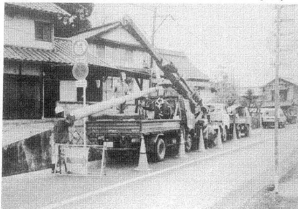
木柱をコンクリート柱に建替える為、準備しているところ
